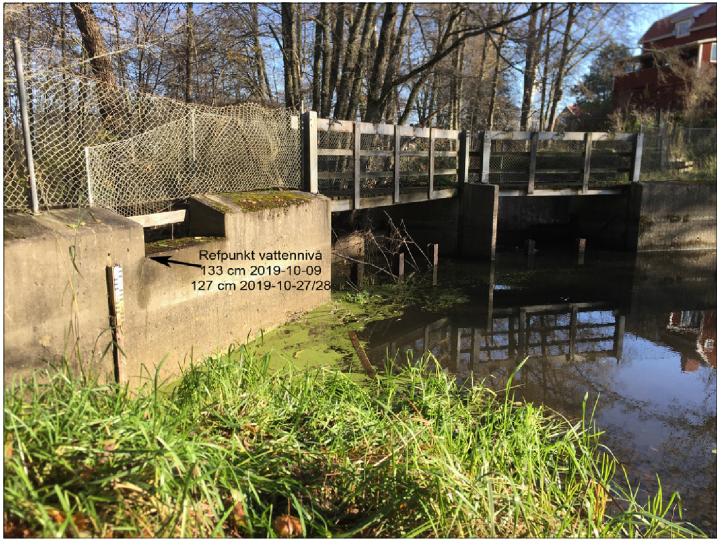
Ref-vattenyta 130 cm under betongkant på utloppsdammen, se foto. Nivån motsvarar 19 cm på pegelskalan. Se foto. (Texten på fotot avser mätnivåer)
